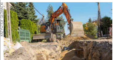
Trwa przebudowa kolejnego fragmentu ulicy Jagiełły
