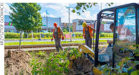
Termin realizacji przejścia dla pieszych na Łódzkiej przy Rudnickiej był kilka razy przesuwany ze względu na sytuację na rynku wykonawców i wzrost cen
