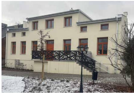
Wyremontowany budynek przy Rembowskiego 3
