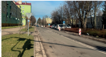
Remont ulicy Cezaka rozpoczął się pod koniec stycznia
