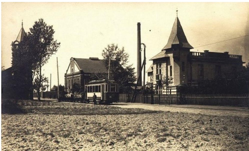
4. Pałacyk na terenie „Zakładów Chemicznych – Boruta”, 1932 r.
