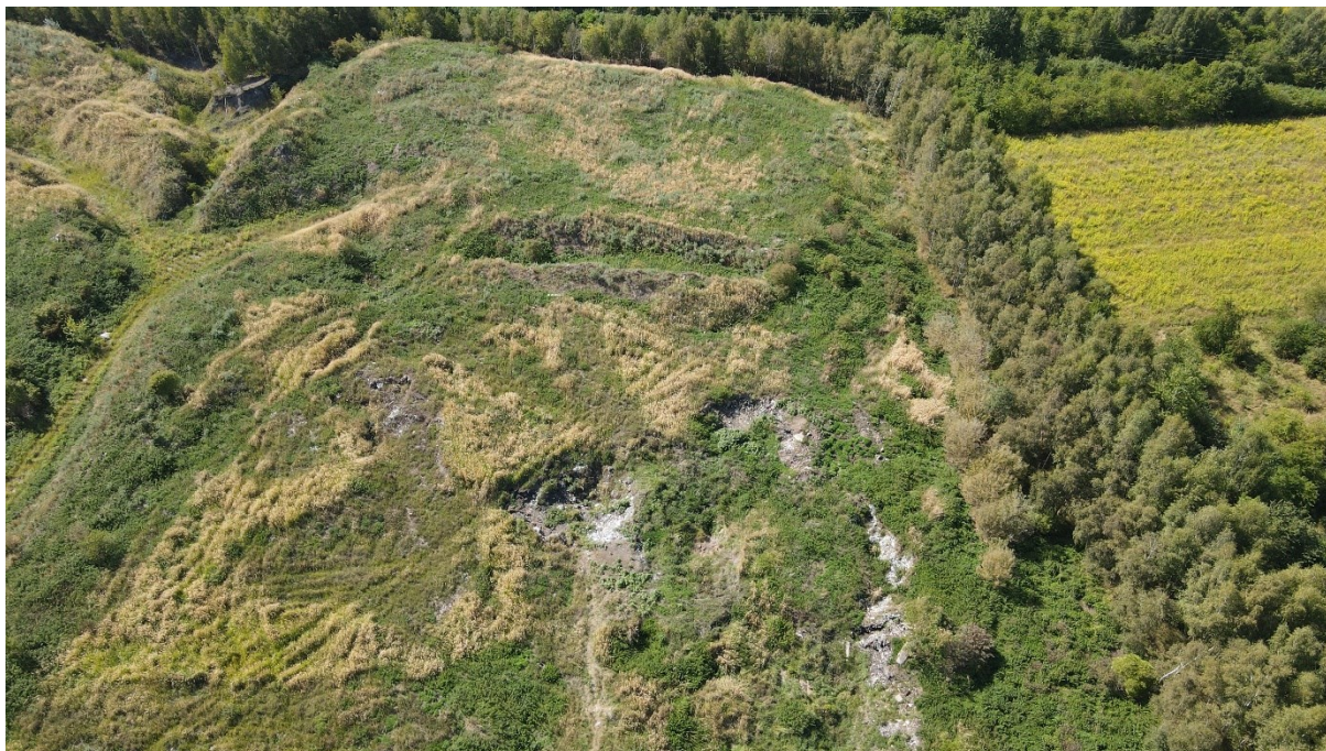
Fot. 3.37. Zdjęcia z drona wierzchniej skarpy składowiska gipsów i popiołów.
