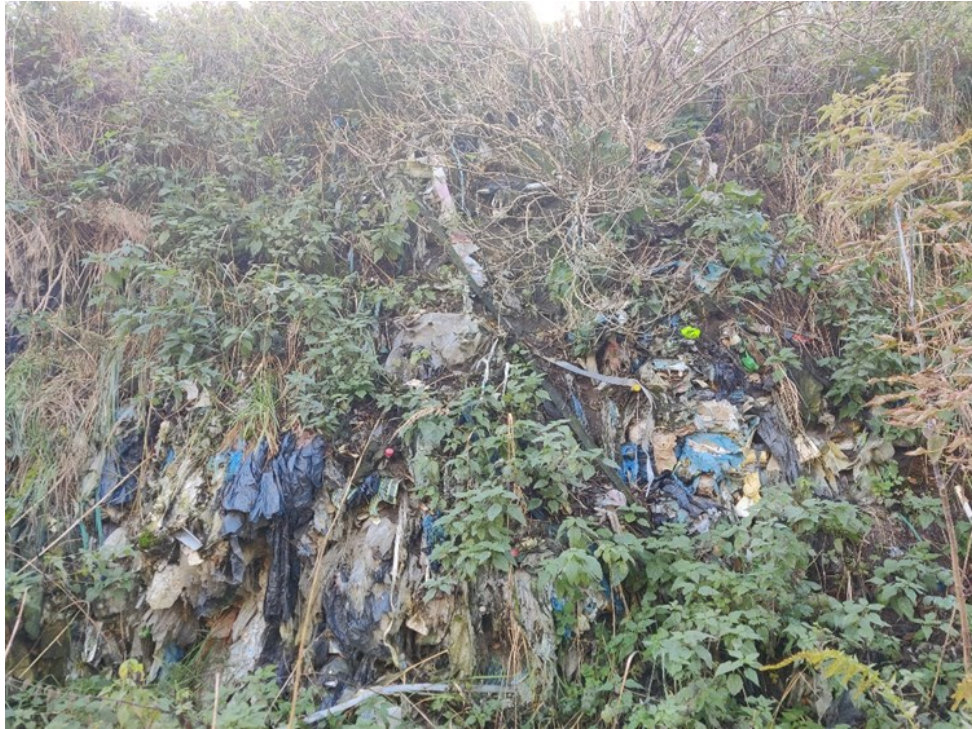
Fot. 3.16. Skarpa hałdy odpadów na składowisku gipsów i popiołów (oznaczona jako B na Fot. 3.19 ).
