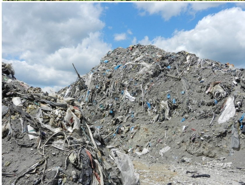
Fot. 3.18. Skarpa hały odpadów na składowisku gipsów i popiołów z widocznymi poprodukcyjnymi odpadami włókienniczymi (oznaczona jako C na Fot. 3.19 ) z 2023 r. (zdjęcie górne) i 2015 roku (zdjęcie dolne – materiał G. Wielgosiński).
