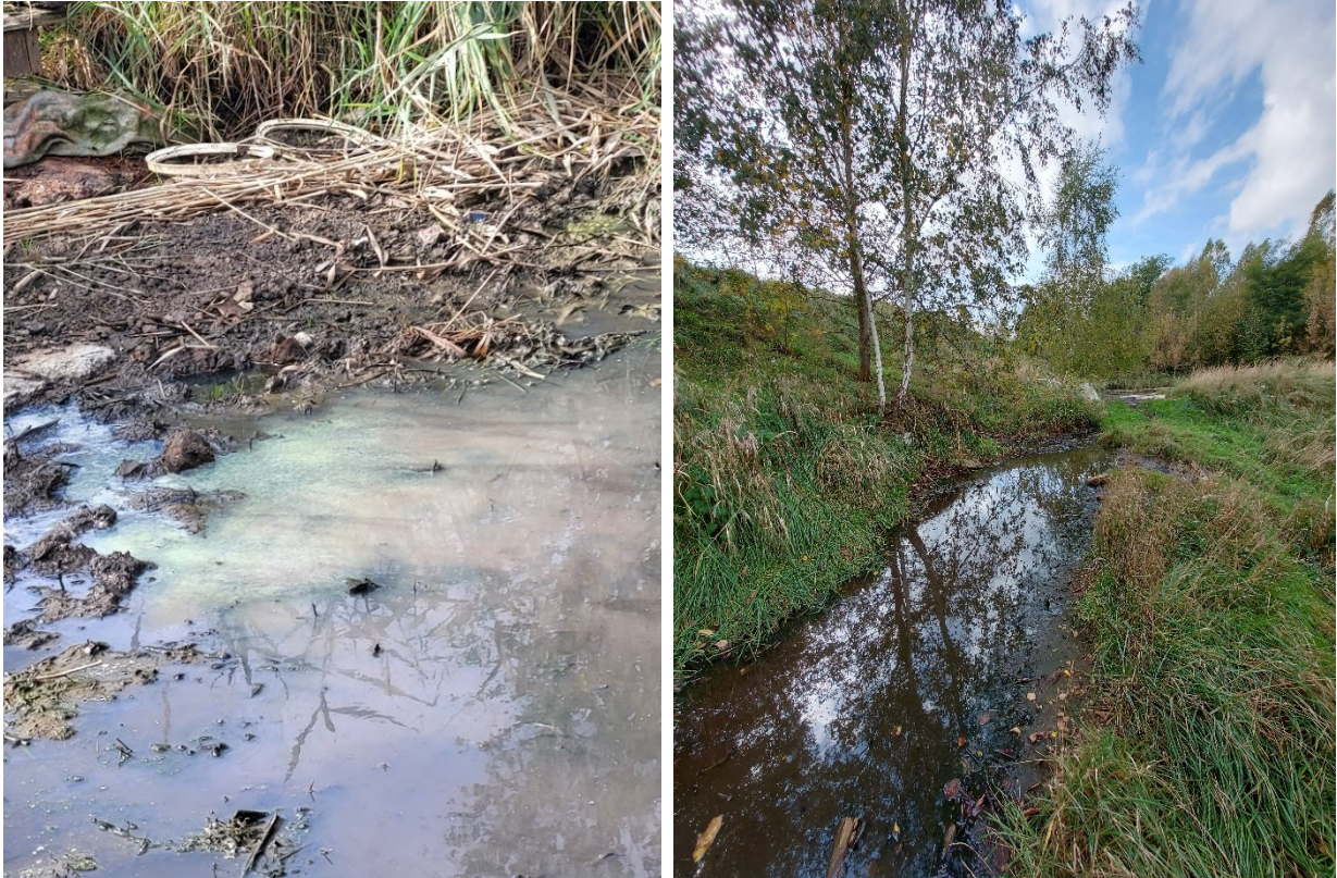
Fot. 3.24. Odcieki u podnóża kwater I (zdjęcie po lewej) oraz rów opaskowy (zdjęcie po prawej) składowiska odpadów poprodukcyjnych, w tym niebezpiecznych przy ul. Miroszewskiej.
