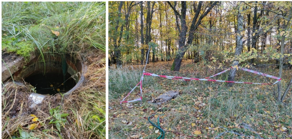
Fot. 3.33. Studzienka zlokalizowana niedaleko składowiska odpadów poprodukcyjnych, w tym niebezpiecznych (lokalizacja na Fot. 3.34 ).
