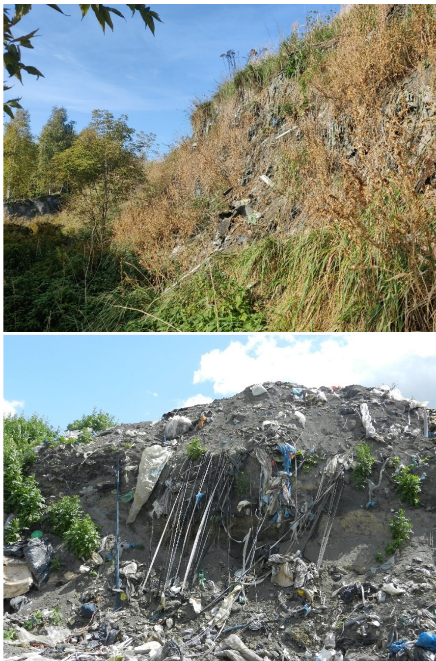
Fot. 3.17. Skarpa hałdy odpadów na składowisku gipsów i popiołów (oznaczona jako C na rysunku Fot. 3.19 ) z 2023 r (zdjęcie górne) i 2015 roku (zdjęcie dolne – materiał G. Wielgosiński).
