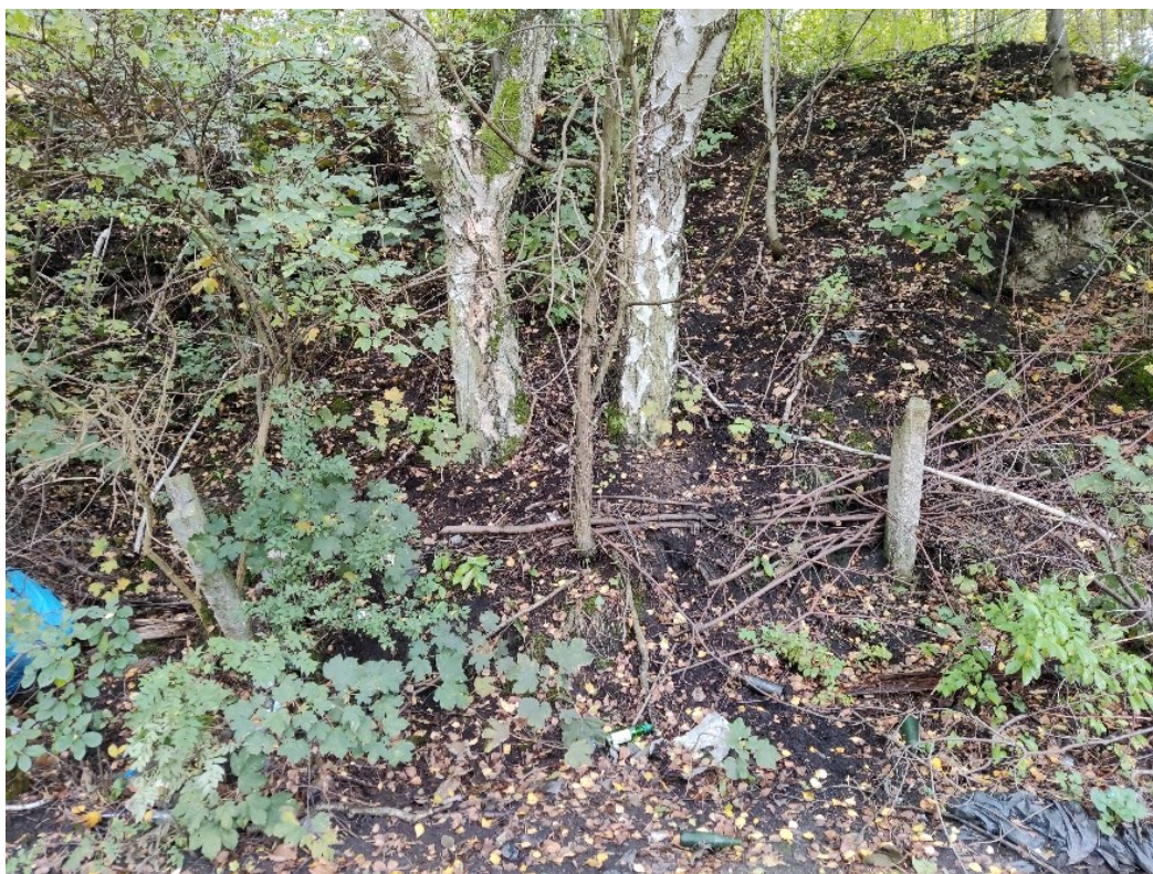
Fot. 3.53. Pozostałość ogrodzenia od strony północnej w miejscu gromadzenia historycznych odpadów przemysłowych (na „Składowisku Za Bzurą”).
