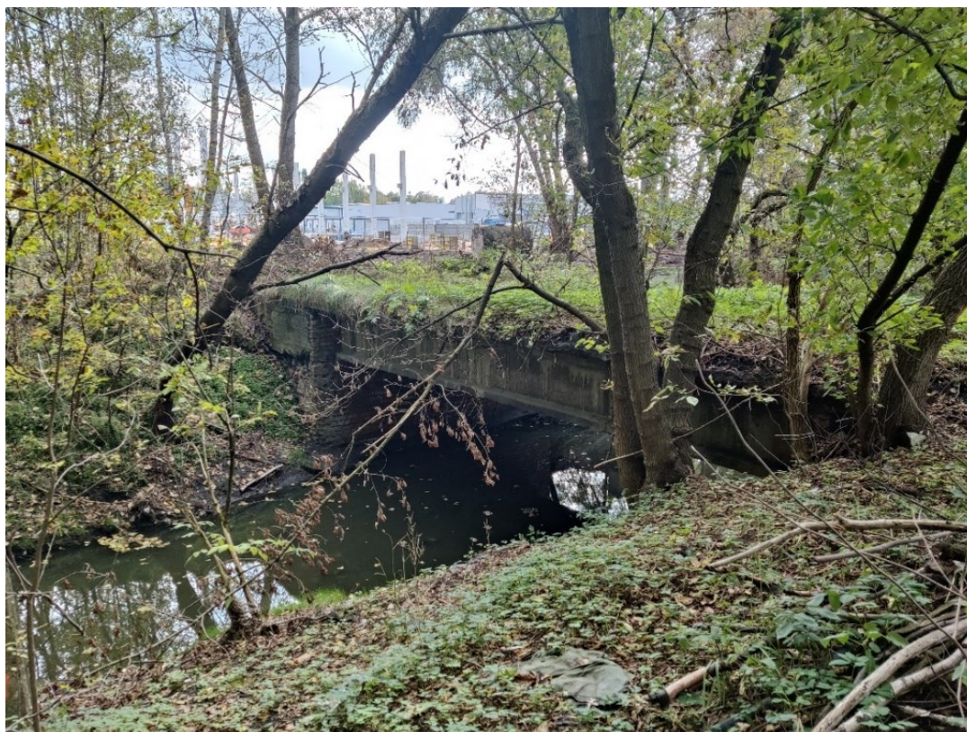
Fot. 3.42. Mostek nad rzeką Bzurą prawdopodobnie stanowiący w przeszłości dojazd do miejsca gromadzenia historycznych odpadów przemysłowych („Składowisko Za Bzurą”) bezpośrednio od strony zakładu.
