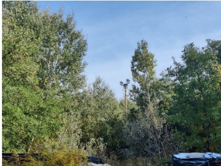
Fot. 3.32. Słup z reflektorami i nieczynną kamerą przemysłową usytuowany obok hydrantu, w okolicy składowiska odpadów poprodukcyjnych, w tym niebezpiecznych (lokalizacja na Fot. 3.34 ).
