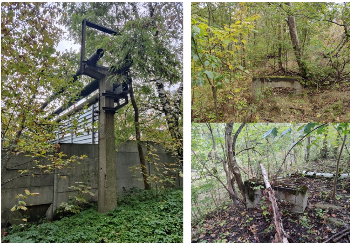
Fot. 3.10. Pozostałości linii odprowadzającej odpady z dawnych zakładów ZPB „Boruta” na składowisko gipsów i popiołów przy ulicy Miroszewskiej.
